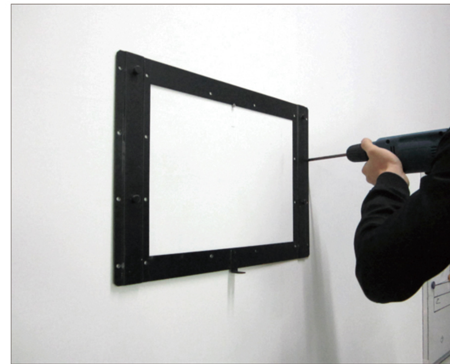
2、将挂板水平贴在墙体，在需要固定螺丝的地方标上记号，用钻头打出定位孔，打进螺丝固定好
